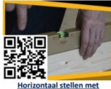
Horizontaal stellen met waterpas
